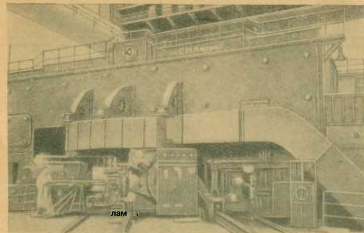
Рис. 23. Общий вид 6-метрового фазотрона Объединенного института ядерных исследований (СССР). На переднем плане — шкаф генератора ускоряющего напряжения.
