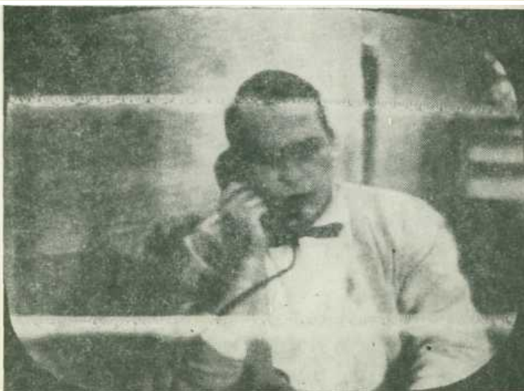
Рис. П.10. Искажение изображения, создаваемое лампой накаливания с зигзагообразной нитью
